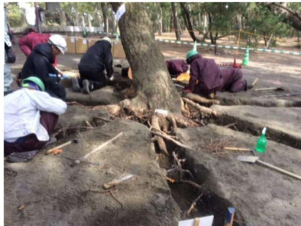
対象となる老齢大木から放射状に固結層を除去・穿孔した上で、土壌改良材(木炭・珪藻土焼成粒)を埋設し、マツと共生しその生育を助ける「菌根菌」の胞子を散布した。
